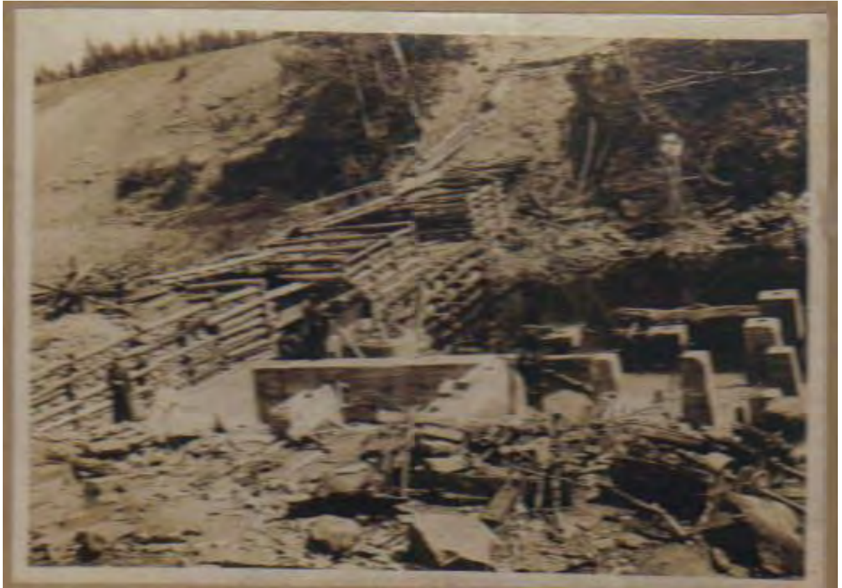
Construction du barrage (Dam) environ 1904.
