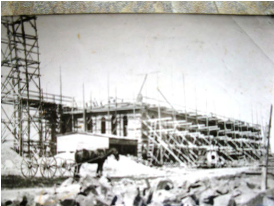
Construction du nouveau Monastère 1927-1931, qui est toujours la en ce jour.
