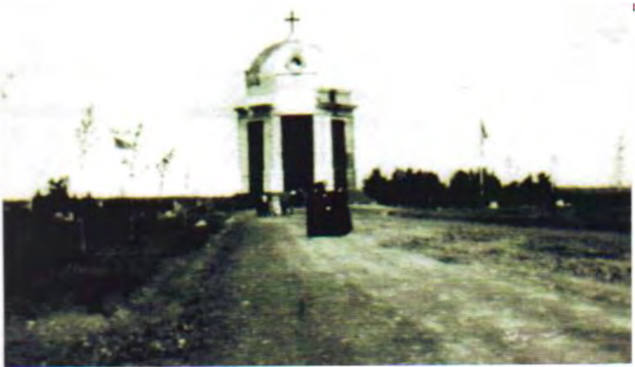
Le Monument en construction
